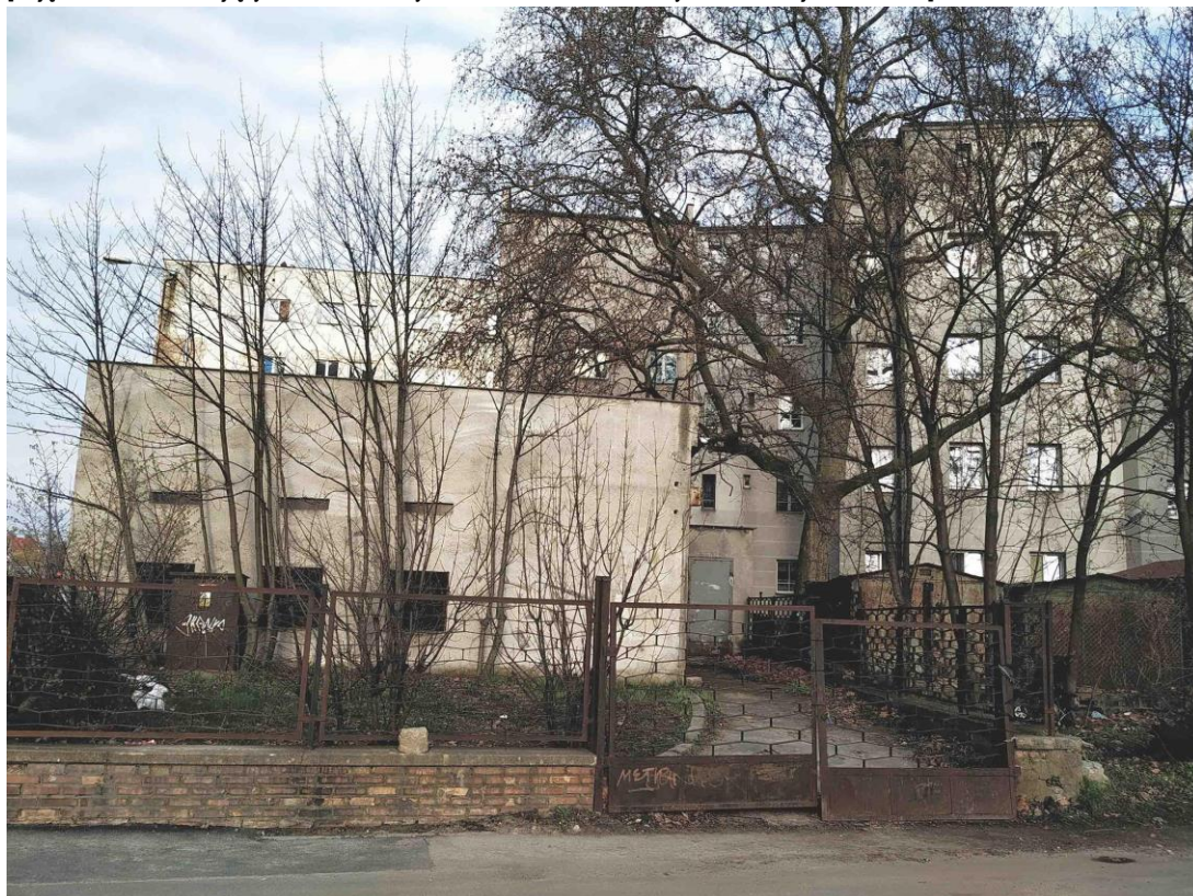
[zdjęcie – stan istniejący – widok od strony zachodniej. 04.2023 r.]
