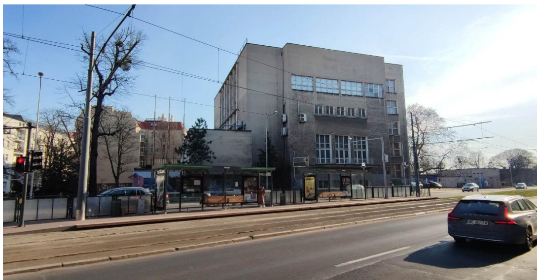
[zdjęcie – stan istniejący – widok od strony północnej, z ul. Grunwaldzkiej. 04.2023 r.]
