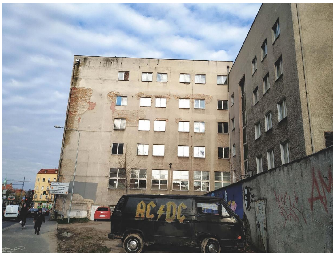
[zdjęcie – stan istniejący – widok budynku od strony zachodniej. 04.2023 r.]
