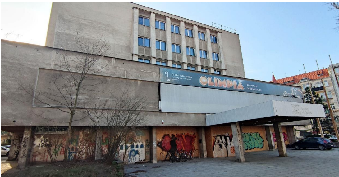
[zdjęcie – stan istniejący – widok wejścia głównego do budynku od strony wschodniej. 04.2023 r.]
