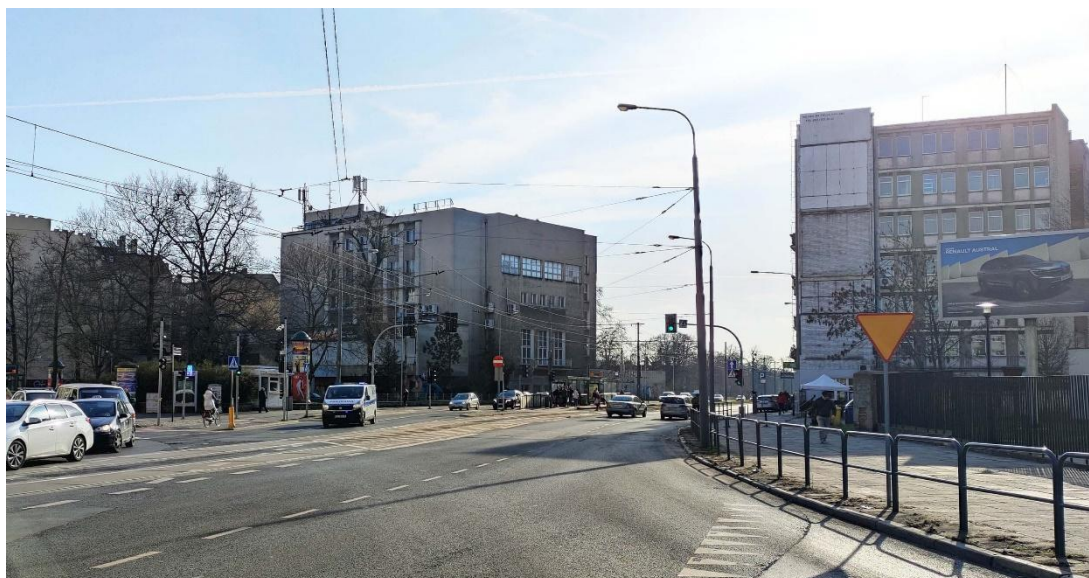
[zdjęcie – stan istniejący – widok od strony północnej, skrzyżowanie ul. Matejki i Grunwaldzkiej. 04.2023 r.]
